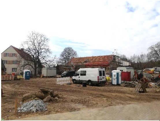
Sanierungsarbeiten am Lindowschen Haus
